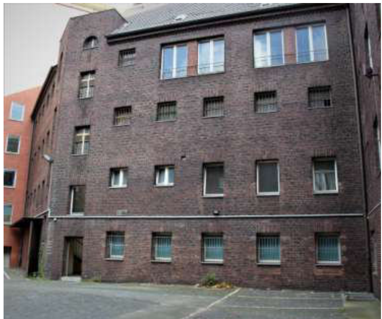
ehem. Polizeigeängnis im Hof des Polizeiamtes Herne (2022)
